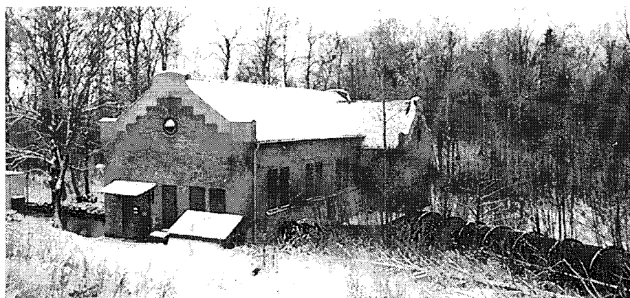
Kraftstationen nedanför dammverket i Skinnskatteberg togs i drift 1908 och är fortfarande i bruk. Foto: J-P Darphin, VLM.
