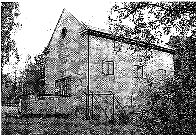
Surahammars nuvarande kraftstation uppfördes under slutet av 1920-talet. Den ersatte ett äldre kraftverk från 1896. Foto: J-P Darphin, VLM.
