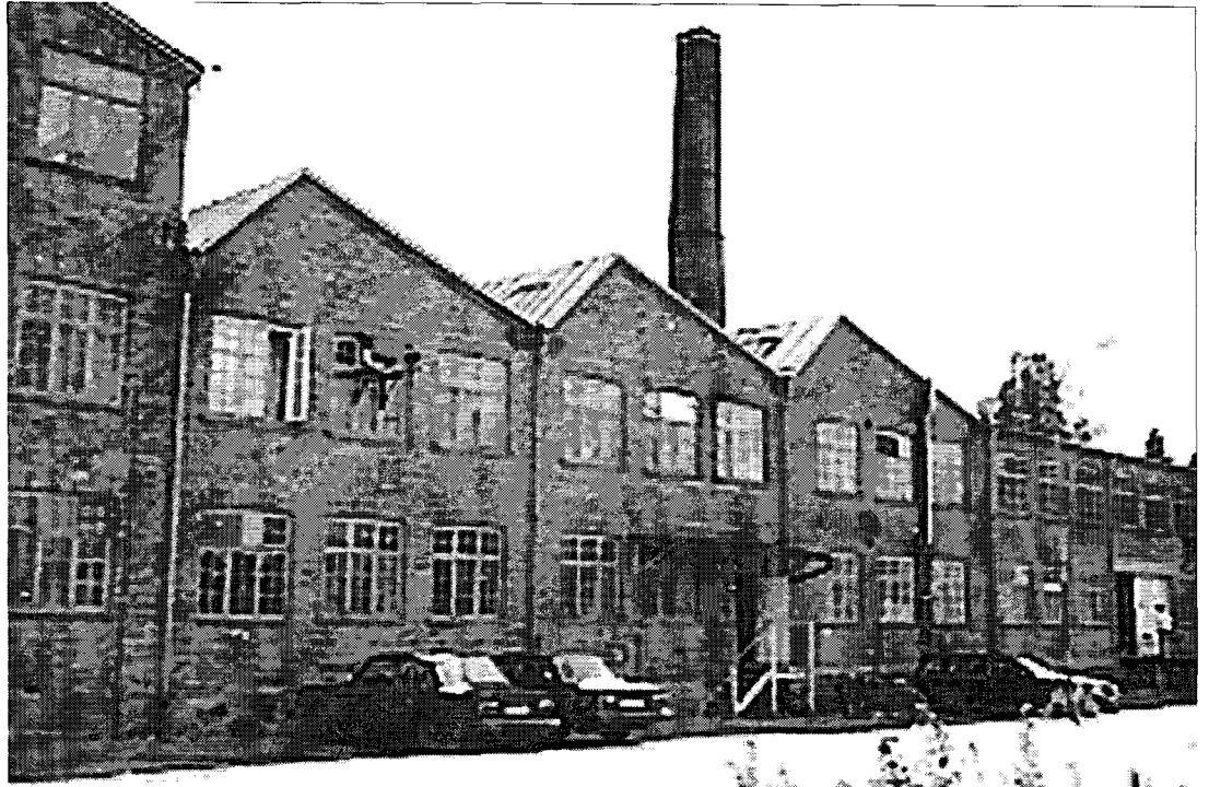
Del av Östlunds Maskinfabriks ursprungliga anläggning i kvarteret Drotten. Foto: J-P Darphin, VLM.
