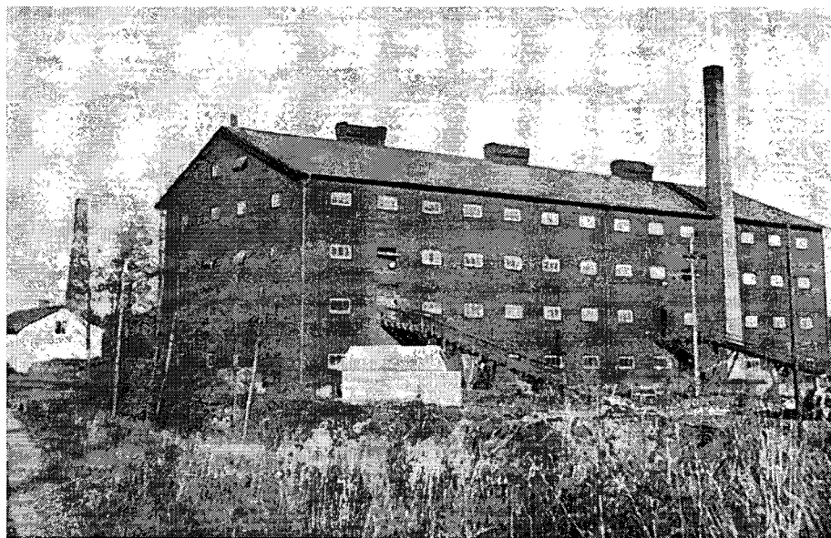
Nyby tegelbruk efter ombyggnaden på 1940-talet. Bild ur Anders Diös bygger i Sala.
