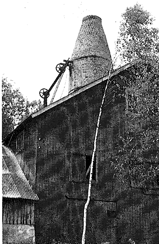
Kalkbruket under Rönnavikens gård drevs mellan 1935 och 1945. Anläggningen med kalkbrott, pumphus, ugnshus, kraftcentral och lös utrustning är bevarad i sin helhet. Foto: J-P Darphin, VLM.
