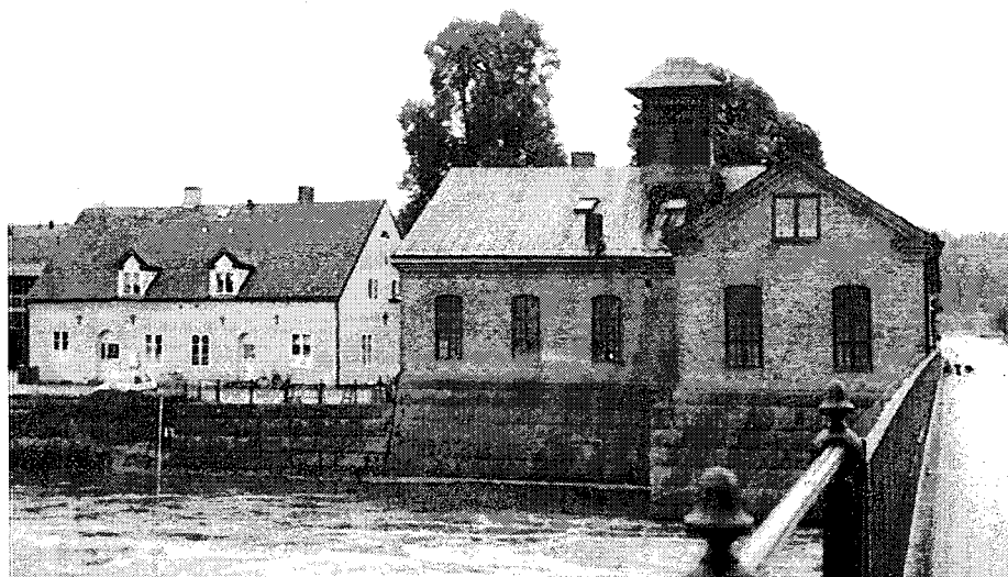
Arbogas kraftverksstation uppfördes, samtidigt som dammen och bron, 1897-99 efter ritningar av den berömda konstruktionsbyrå, Quist & Gjers. Foto: J-P Darphin, VLM.
