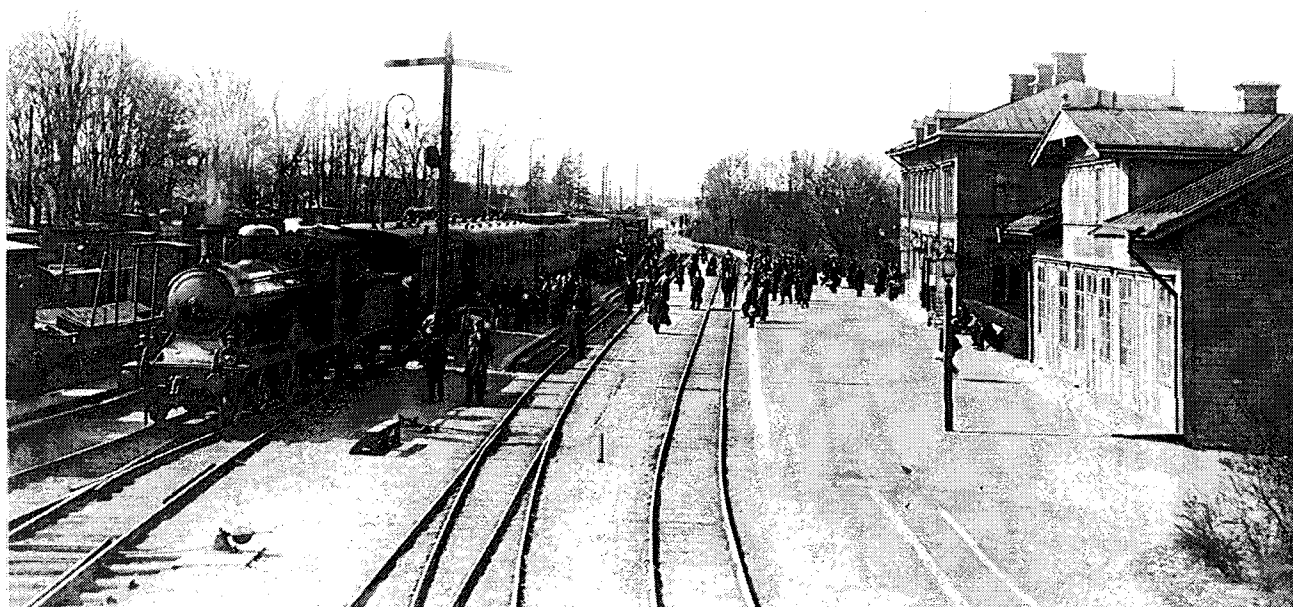
Invigningen 1876 av sträckan Köping- Stockholm medförde att staden följande år fick ytterligare en stationsbyggnad, nuvarande station. Foto: VLM:s arkiv.
