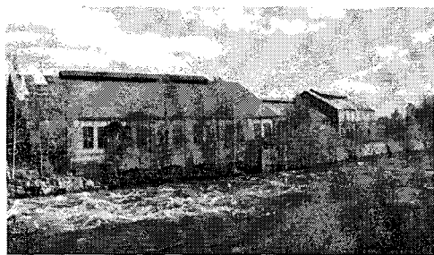
Hallsta Bruks valsverksbyggnad kort före rivningen 1986. Foto: VLM:s arkiv.
