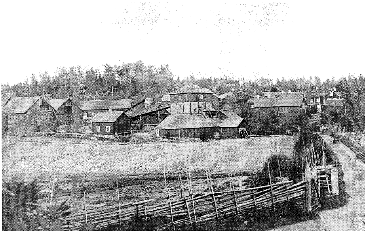
Bråfors hytta och bergsmansby på 1870-talet. Längst till vänster syns större kolhus och i bildens mitt masugnen. Foto: VLM:s arkiv.
