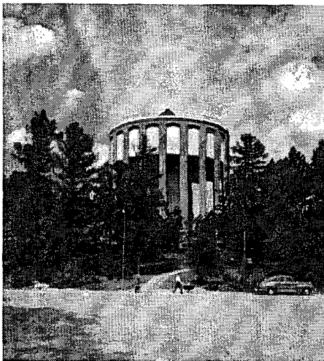
Vattentornet på Skallberget uppfördes 1952 efter ritningar av stadsarkitekten Per Bohlin. Det var ett komplement till det äldre tornet på Djäkneberget. Foto: VLM:s arkiv.
