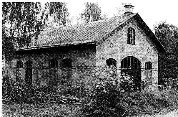
Ovan. Västanfors gamla kraftstation 1990, inför renoveringen. Foto: VLM:s arkiv.
